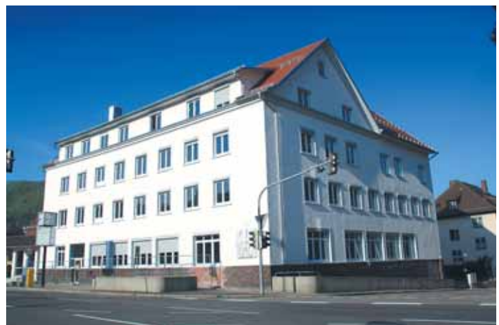
HfWU Nürtingen-Geislingen, Hochschulgebäude in der Bahnhofstraße am Standort Geislingen
