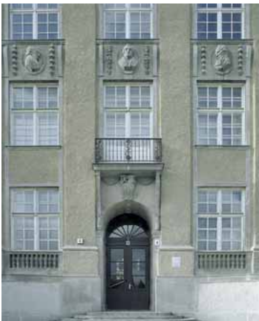
HTW Berlin, Gebäude Treskowallee Nr. 8
